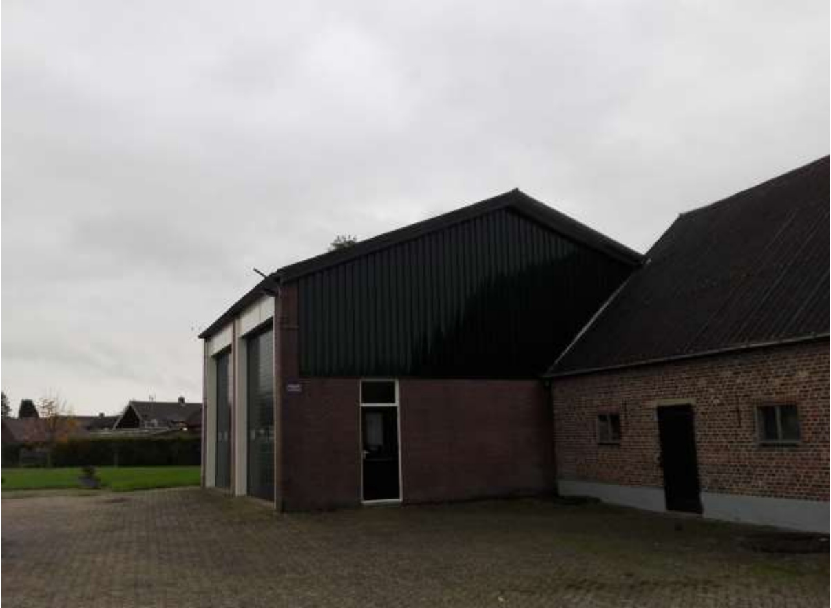
Impressie voormalige werkplaats en opslagruimte (deels) in oostelijke richting
